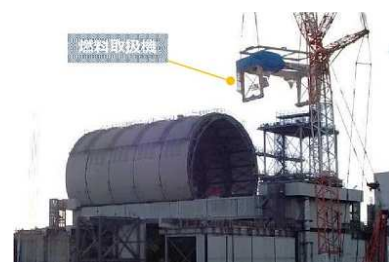
大型クレーンで3号機原子炉建屋億上部に設置される燃料取扱機(11月12日午前)福島民報
